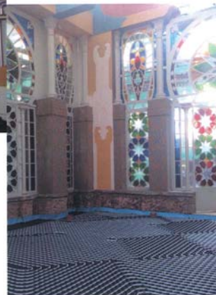
Da sinistra, in senso orario, installazione di un impianto fotovoltaico, particolare di una centrale termo frigorifera e posa in opera di pannelli radianti
